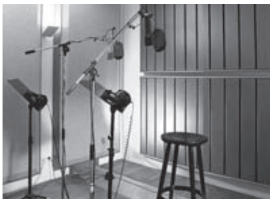
Abb. 88: Sprachaufnahmerraum mit Schlitzplattenschwängern und Breitbandabsorbern (mit freundlicher Genehmigung von Giesingteam).
