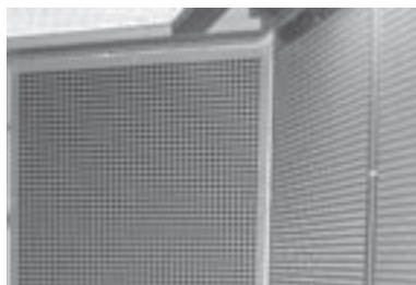
Abb. 86: Wandausschnitt mit Lochplattenschwingern
