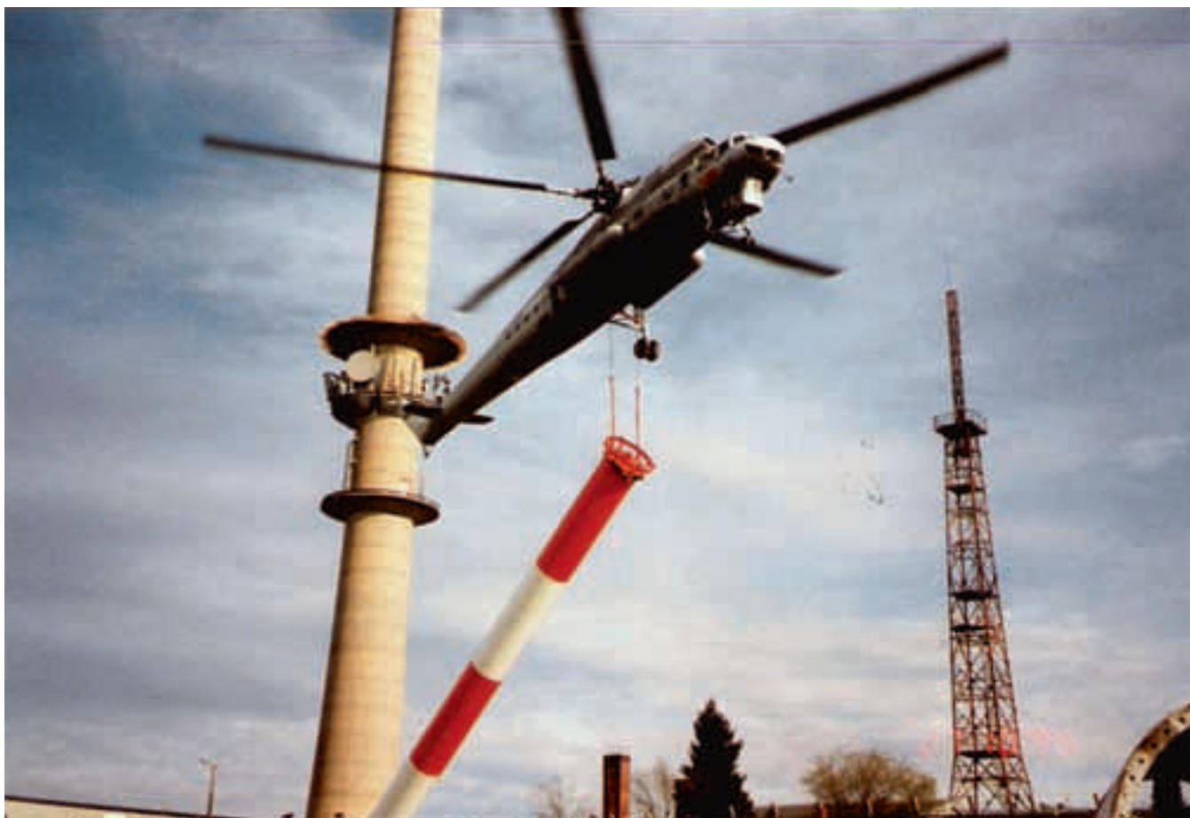
Die Mi-10k hebt das 8,2 Tonnen schwere, mit einem Kunststoffzylinder ummantelte Antennensystem.
